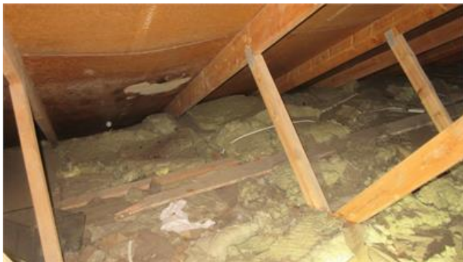
Lagning underlagstak pånockvind.
